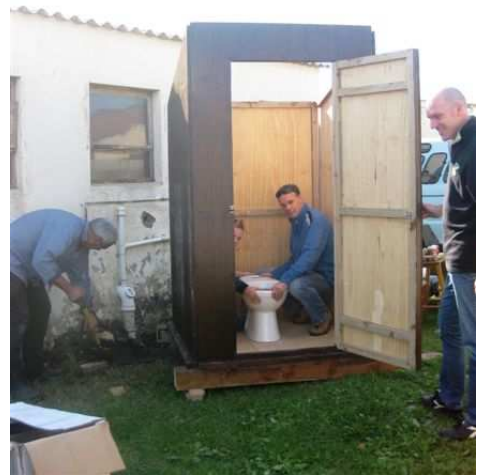
Met Theo en Thom een toilet geplaatst in de sloppenwijk
